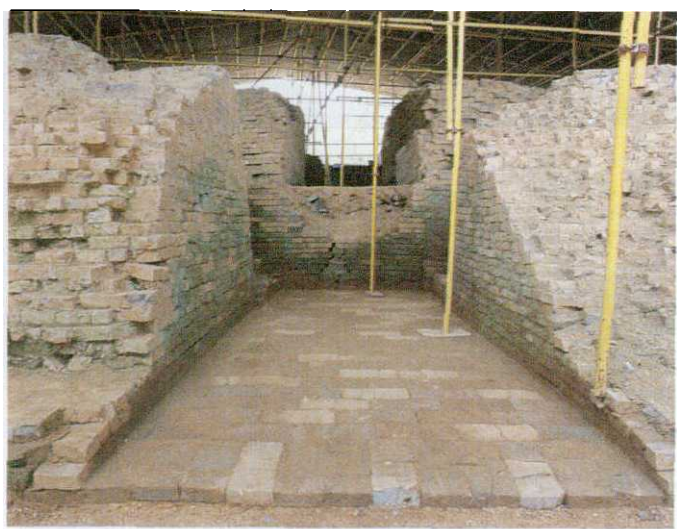
图一一 塔北门门道
